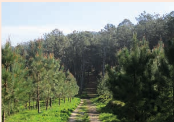
Pista forestal ancha adecuada para su desbroce con máquina, con firme y drenaje en buen estado.
