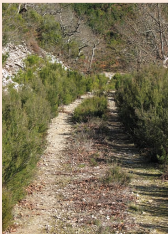
Pista estrecha en mal estado que requiere desbroce de vegetación en los márgenes.
